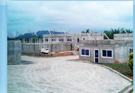
Station de traitement d'eau potable de Nsawman (Ghana) - GHANA WATER - 7.400 m 3 /jour
