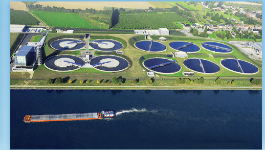
Station d'épuration de Liège-Oupeye (Belgique) AIDE - 446.500 EH
