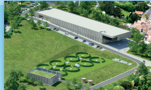
Station de traitement d'eau potable à Ans (Belgique) CILE - 35.000 m 3 /jour
