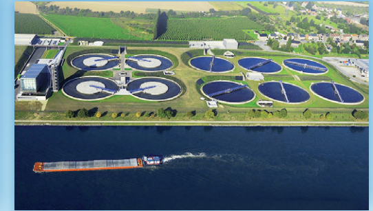
Station d'épuration de Liège-Oupeye (Belgique) AIDE - 446.500 EH
