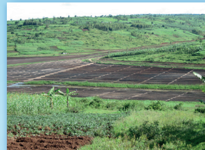
Irrigation du marais de Kanyonyomba (Rwanda) 63 km de canaux sur 600 ha
