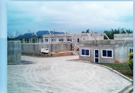
Station de traitement d'eau potable de Nsawman (Ghana) - GHANA WATER - 7.400 m 3 /jour
