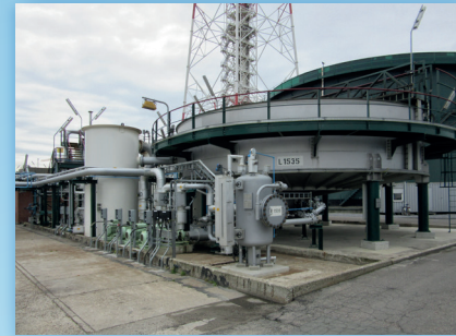
Station de traitement d'eau industrielle à Anvers (Belgique) - TOTAL - 7.200 m 3 /jour
