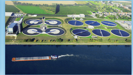
Station d'épuration de Liège-Oupeye (Belgique) AIDE - 446.500 EH
